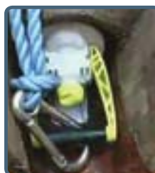
OBTURATEUR VEROUILLE. CANALISATION FERMEE
